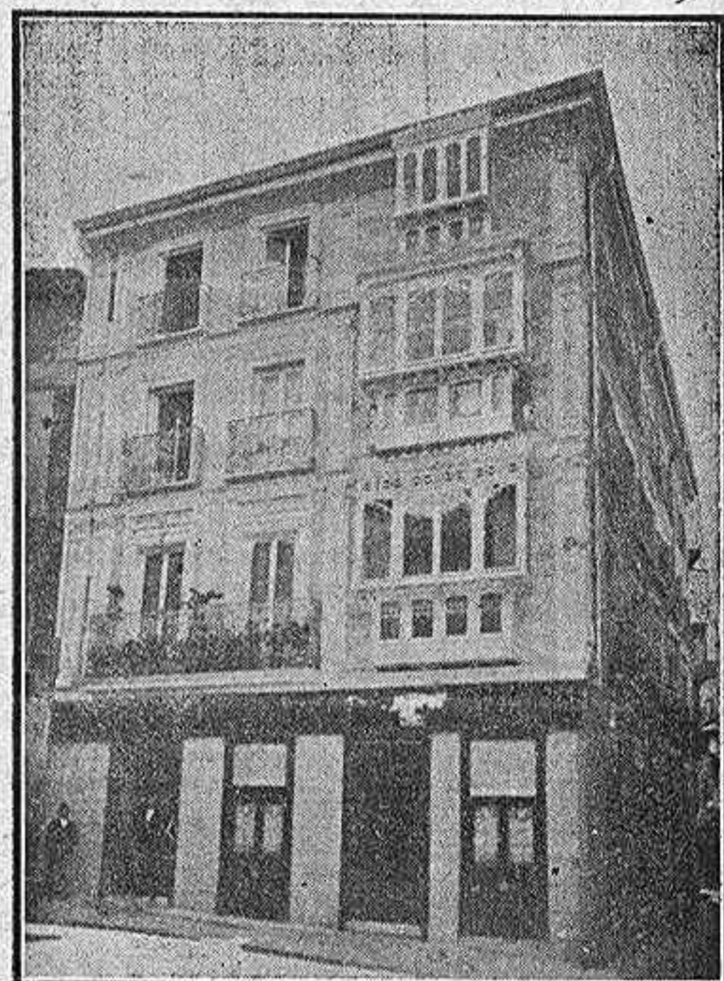
Barrio Rey, 2, 4 y 6, Teléfono 14, TOLEDO
