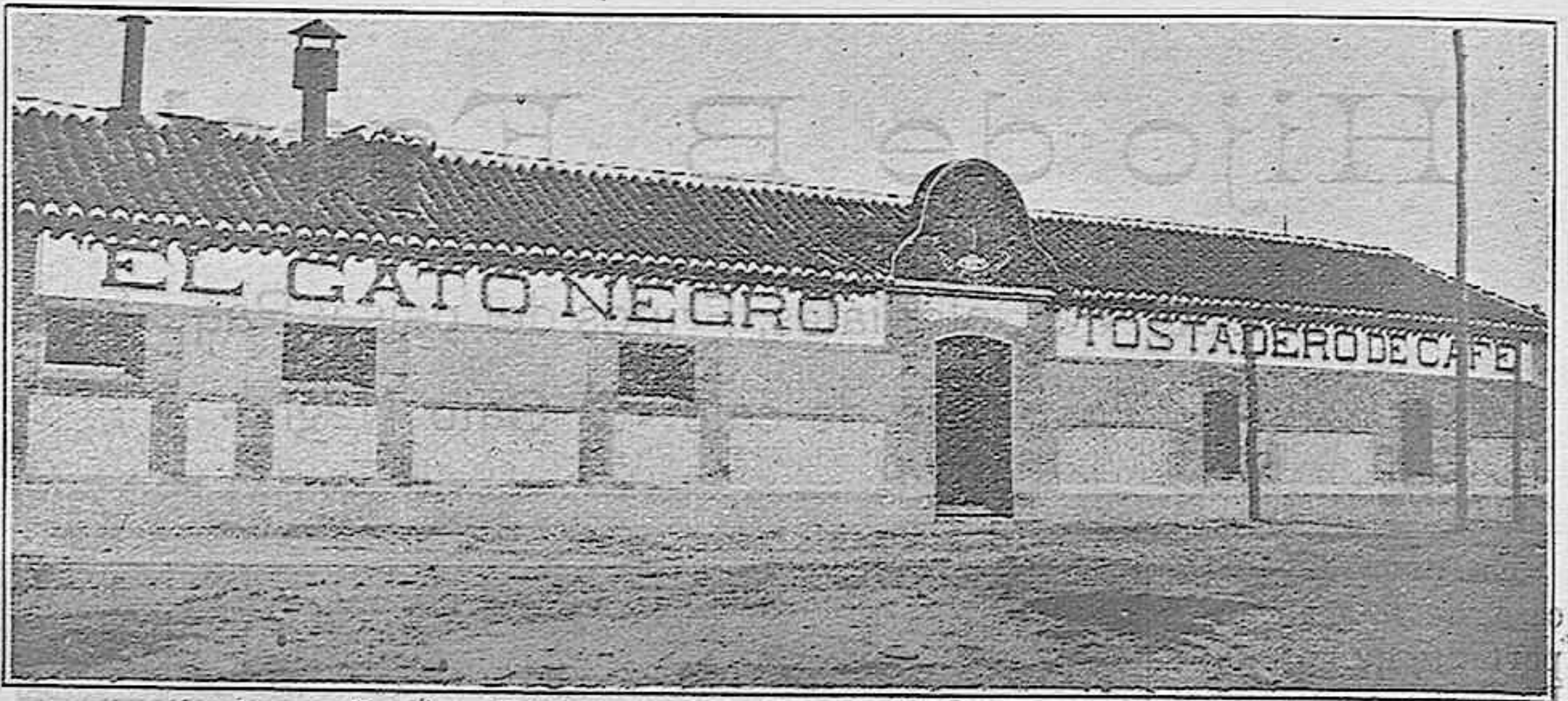
Fachada del tostadero.
