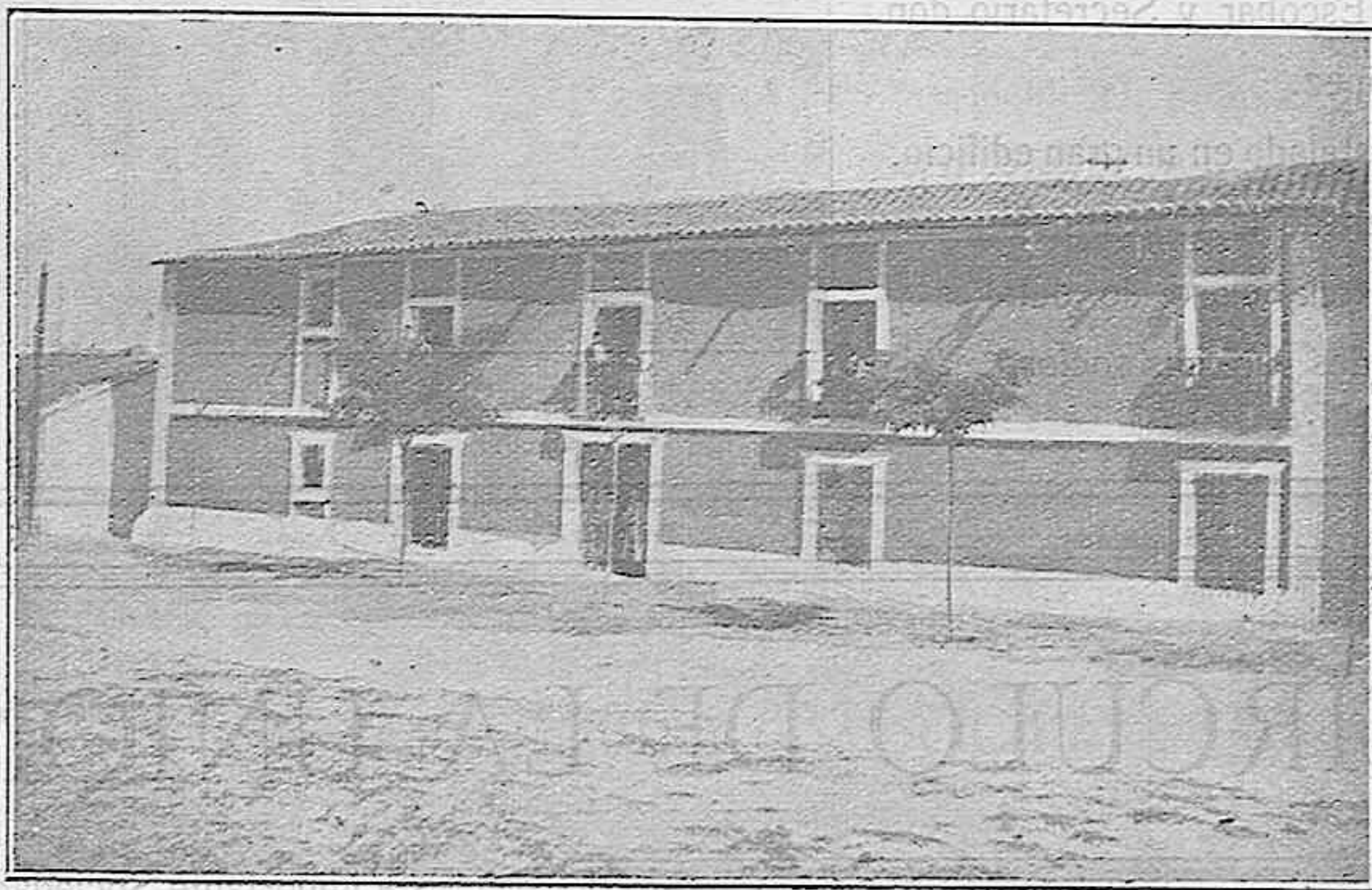
Fachada del internado.
