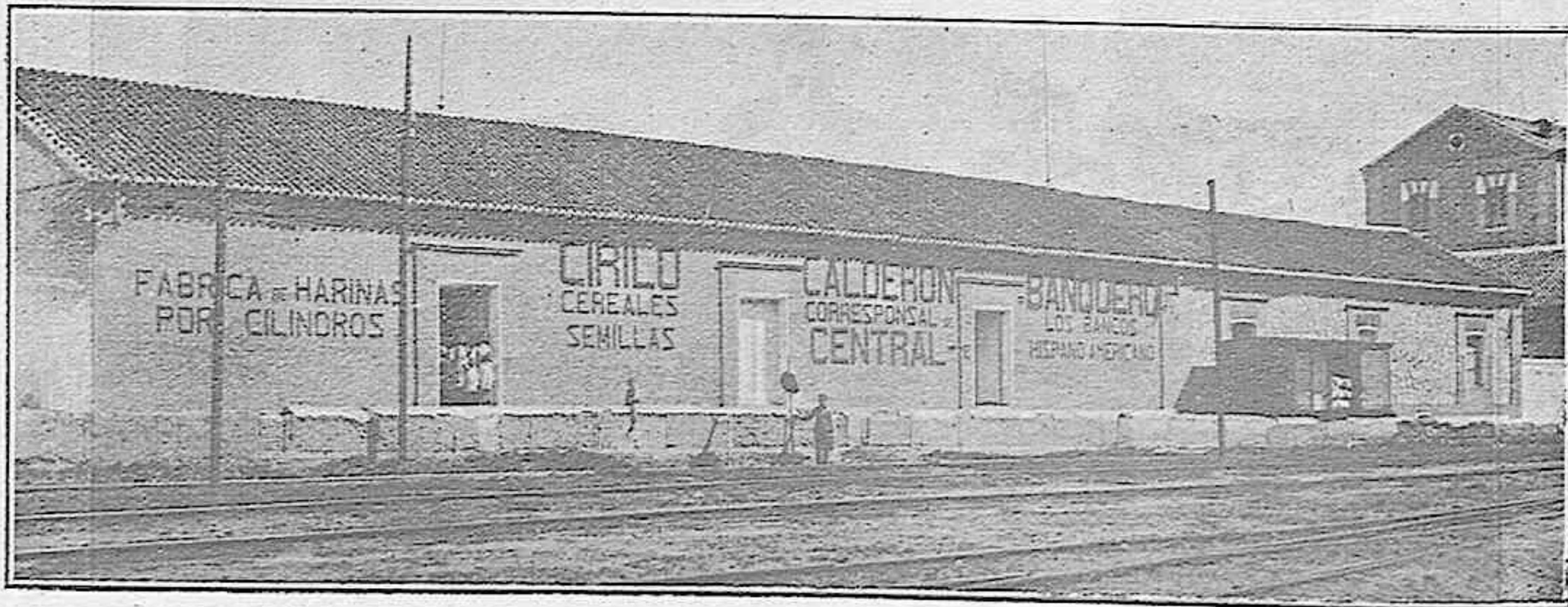
Fachada de Almacenes y Bodega al apartadero de la vía férrea.
