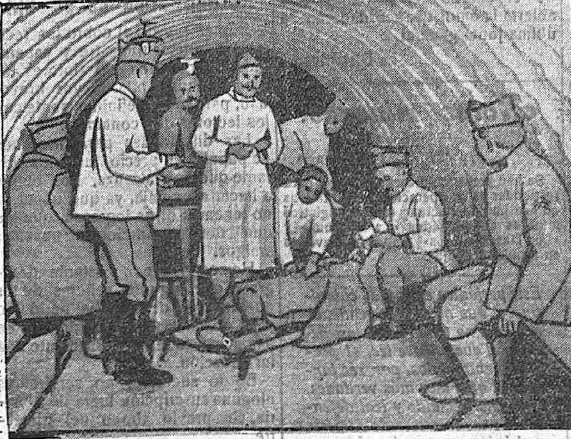
SALA SUBTERRANEA DE UN CENTRO QUIRURGICO AVANZADO. Foto: Información
