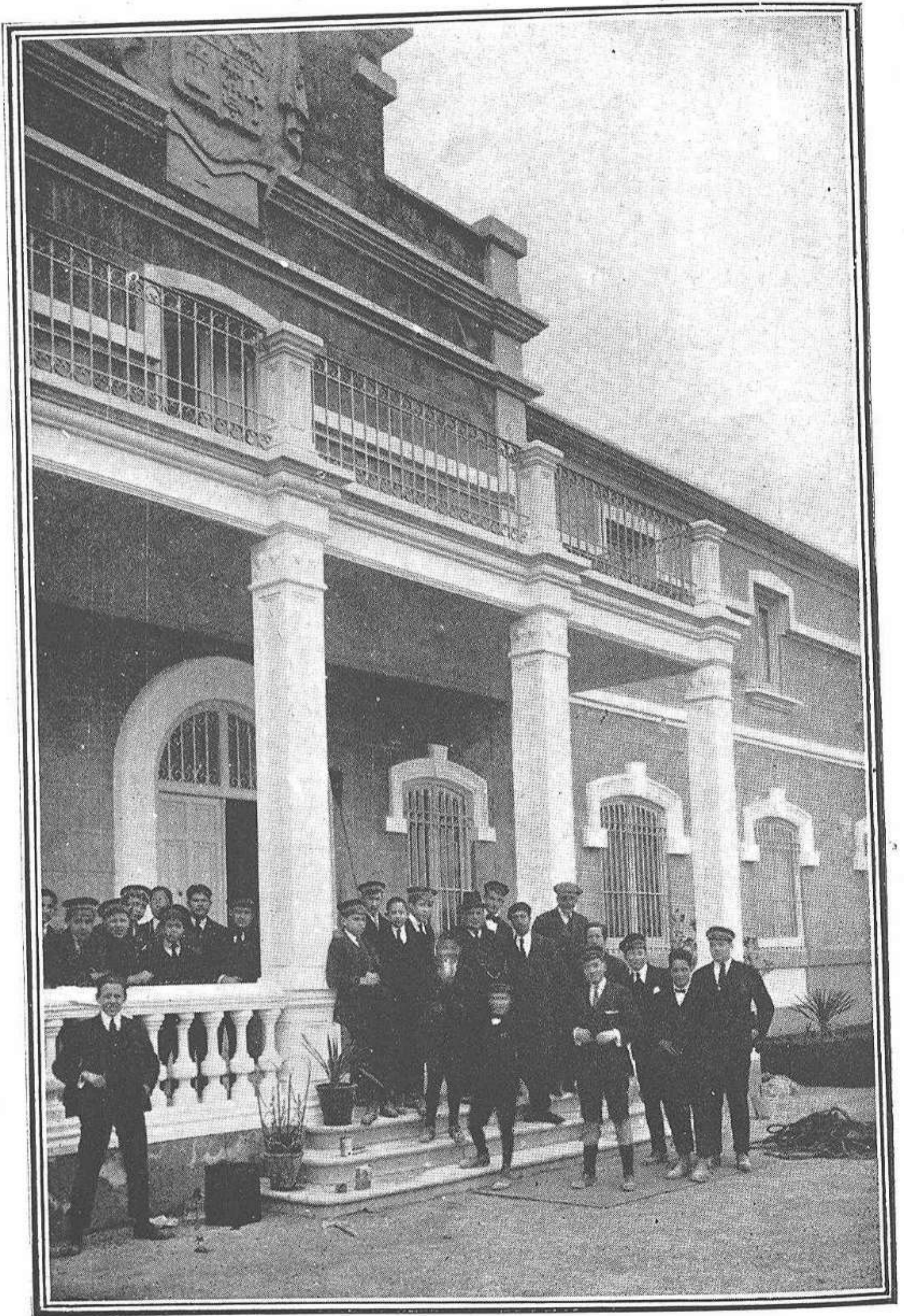
PALACIO DEL SR. MARQUÉS DE CUBAS — JACARILLA
