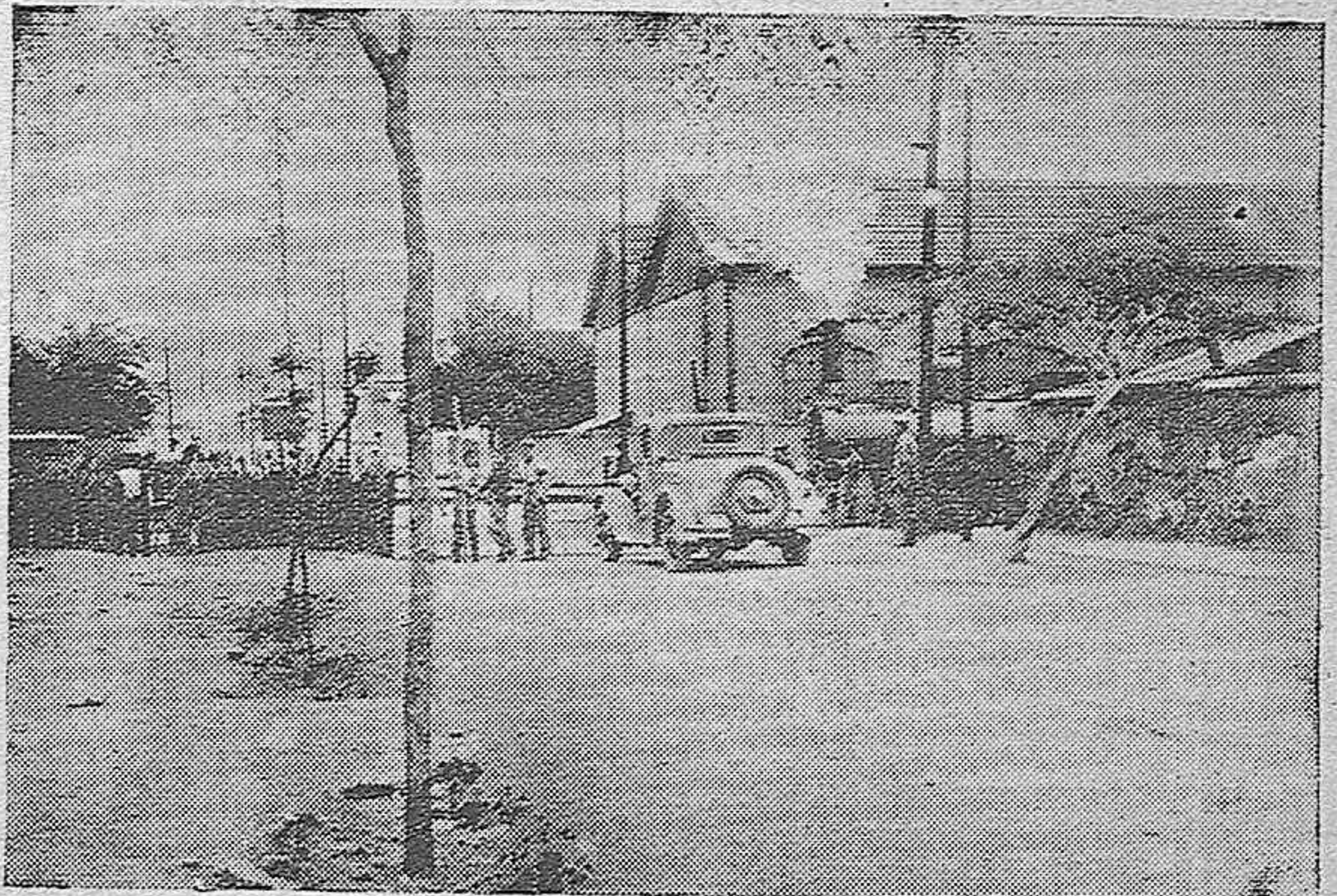
Doble paso a nivel de las Margaritas, preocupación constante de la excelentísima Diputación provincial, por las dificultades y peligros que presentan para el tráfico y por estar enclavado en uno de los caminos vecinales de su gestión.
