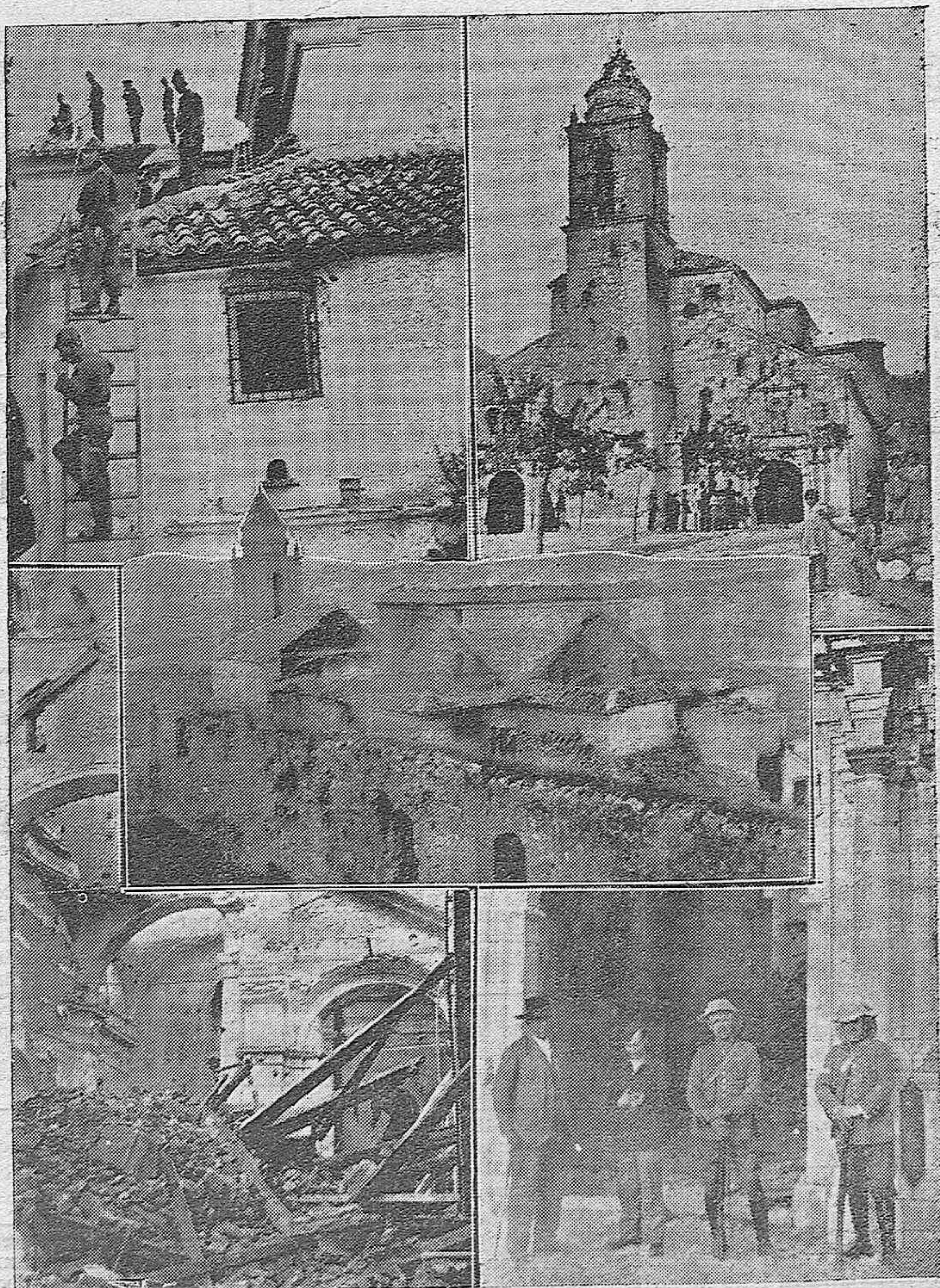
EL INCENDIO DE LA IGLESIA DE DOÑA MENCIA.—Varios aspectos del siniestro, a causa del cual ha quedado destruida una joya arquitectónica de extraordinario valor
