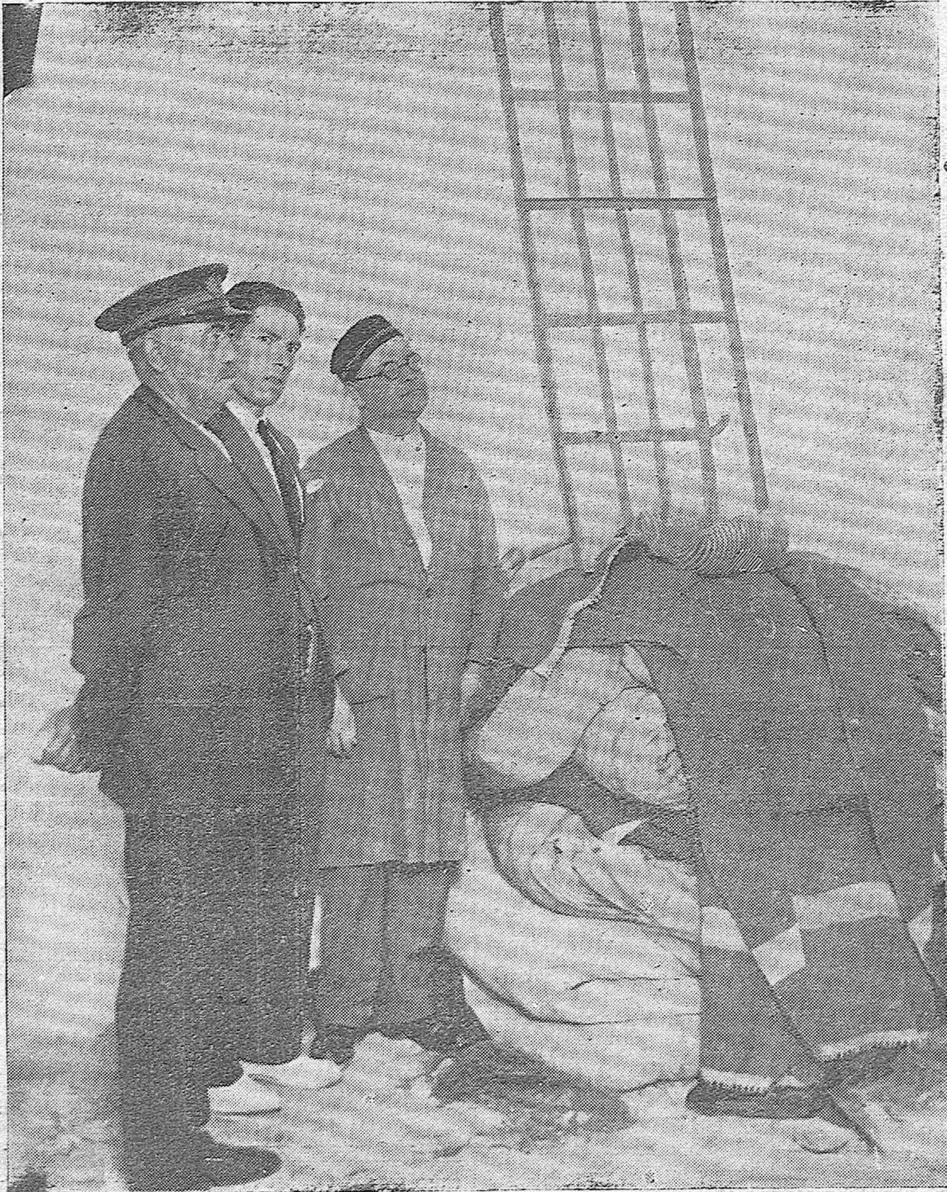
LA FUGA DE UNOS PRESOS.—Vista del interior de la celda tal y como fué hallada después de la fuga de los cuatro reclusos. Los colchones y parte de un somier sirvieron para escalar la bóveda por cuyo agujero increíble escaparon
