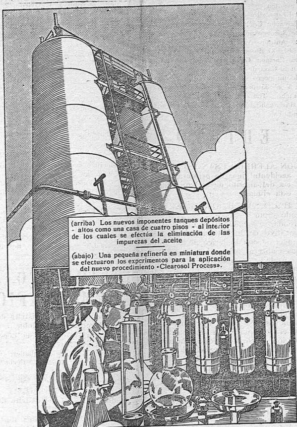
(arriba) Los nuevos imponentes tanques depósitos altos como una casa de cuatro pisos - al interior de los cuales se efectúa la eliminación de las impurezas del aceite
