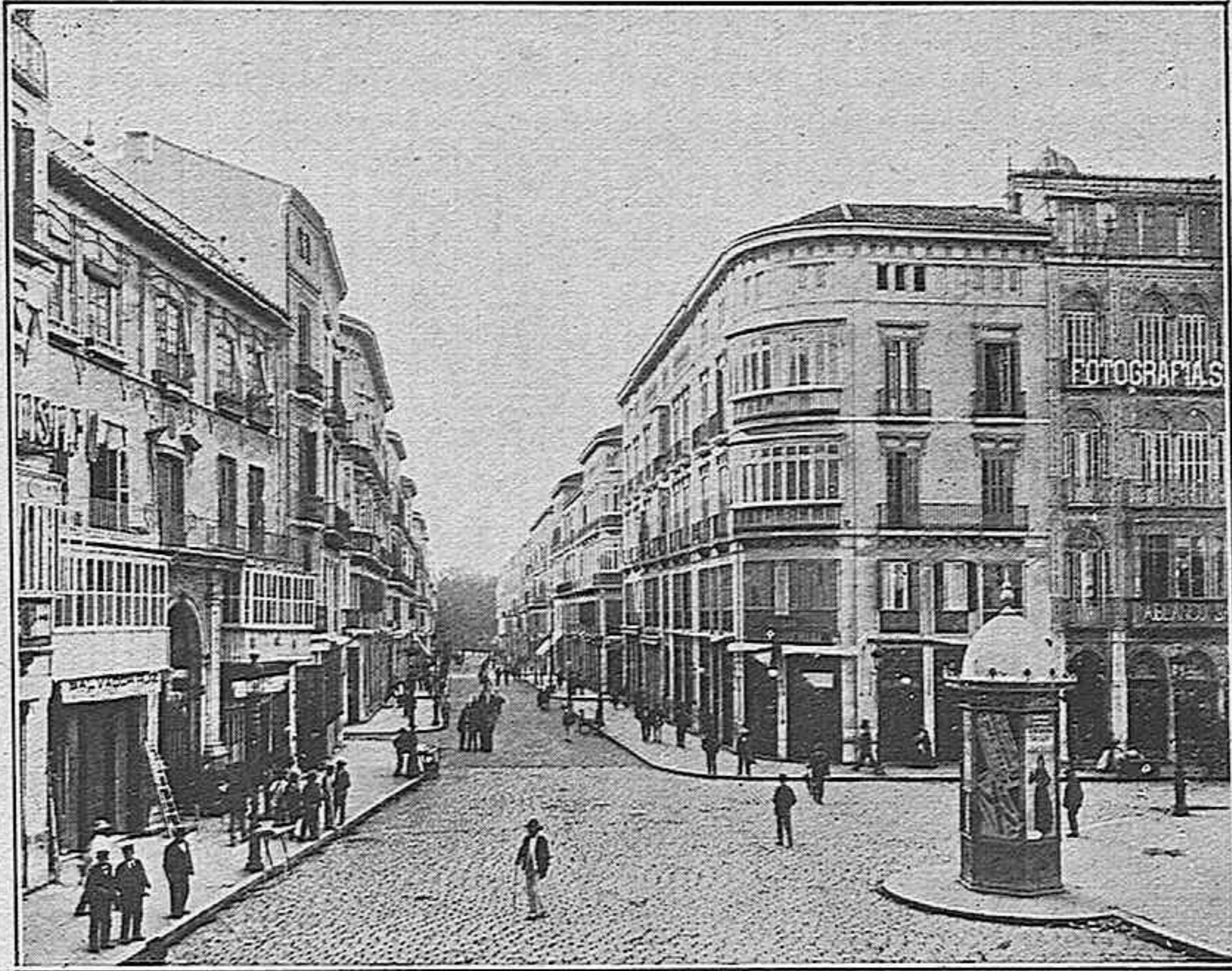
MÁLAGA.-LA CALLE DE LARIOS, ARTERIA PRINCIPAL DE LA CIUDAD, QUE MARCÓ UNA ÉPOCA EN LA URBANIZACIÓN DE LAS POBLACIONES DE ESPAÑA
