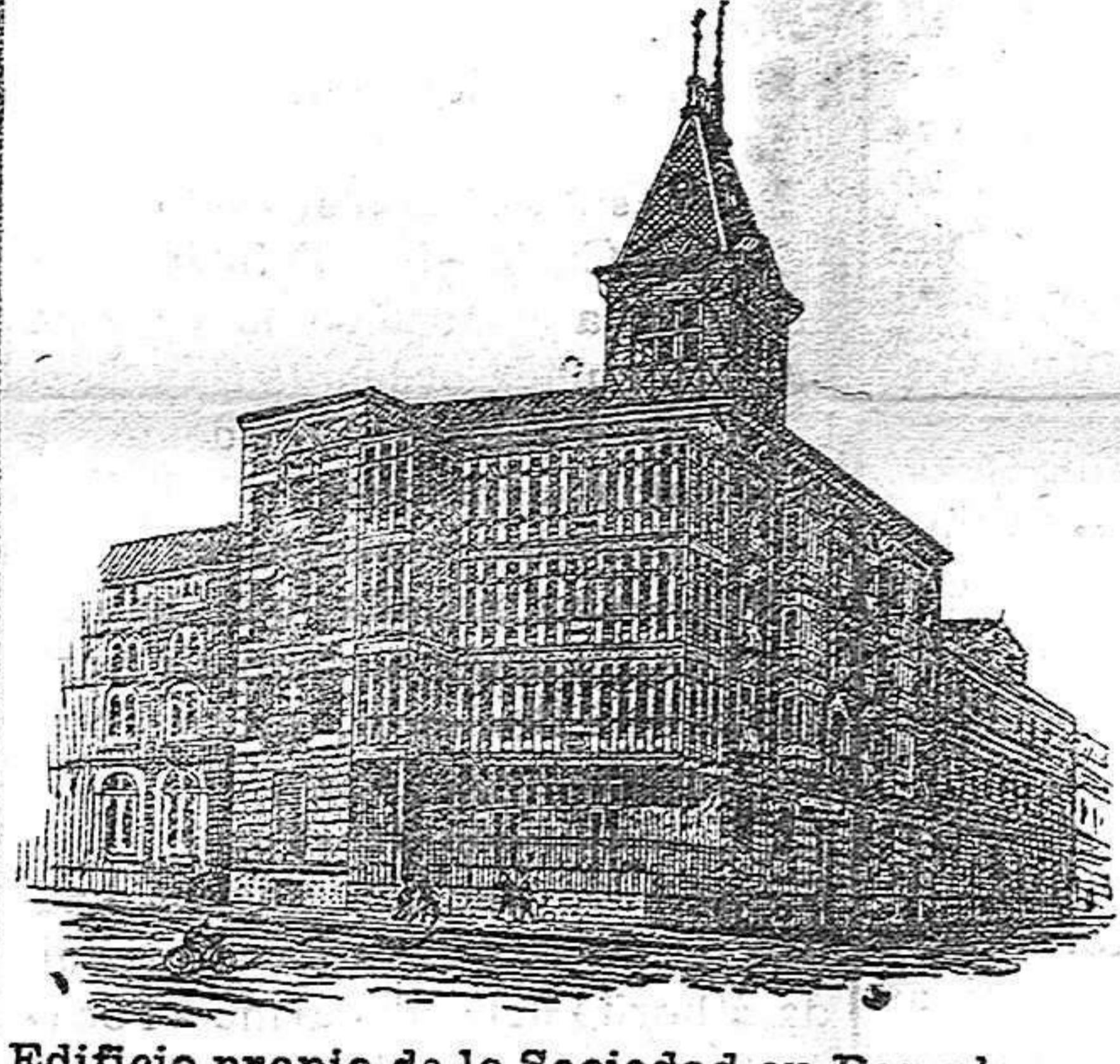
Edificio propio de la Sociedad en Pamplona
