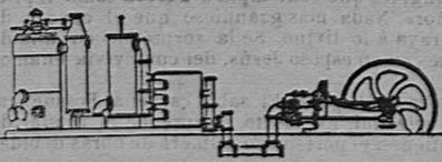
Motores á gas. Legítimos motores (ROSSLEY para gas pobre, petróleo, alcohol, etc.) de todas potencias.—Gasógenos sistema CROSSLEY, sin gasómetro ni caldera.—Gasógenos sistema LOWSON.—Calderas y máquinas de vapor Davey Paxman y C.—Instalaciones completas de alumbrado eléctrico, transporte de fuerza, tracción eléctrica.—Bombas centrifugas.—Bombas Blake.
