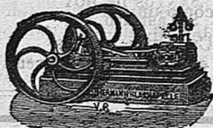
MAQUINAS DE VAPOR PARA INSTALACIONES DE LUZ ELÉCTRICA
