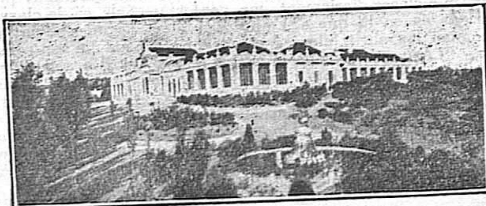
Escoles «Ribas» Rubí. Vista general
