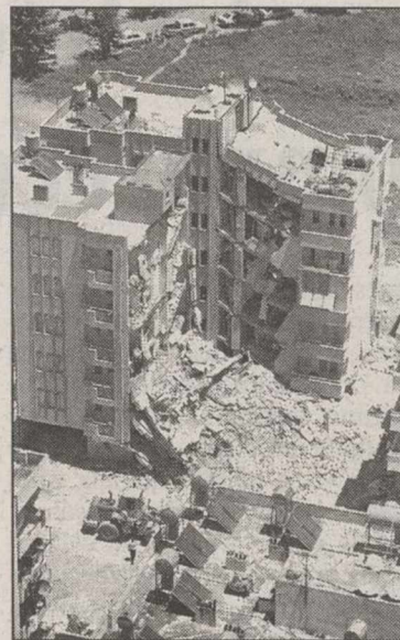
El temblor alcanzó los 6,3 grados.
