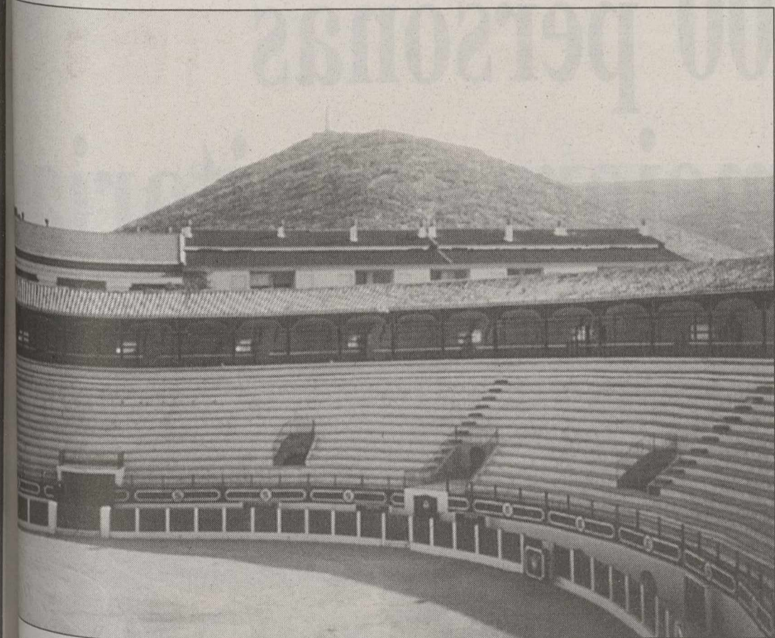
no hay nada en concreto sobre la cubierta de la Plaza de Toros para evitar suspensiones.
