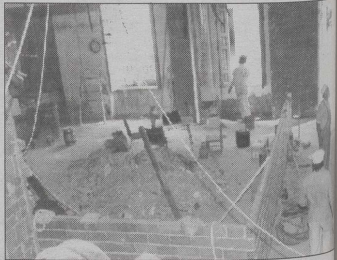
Las obras deben quedar acabadas una semana antes de la inauguración.
