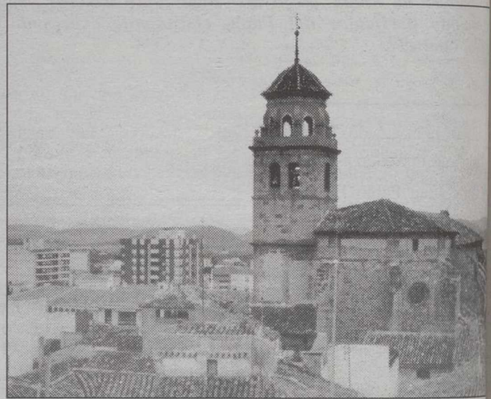
Reparaciones en la Parroquia.
