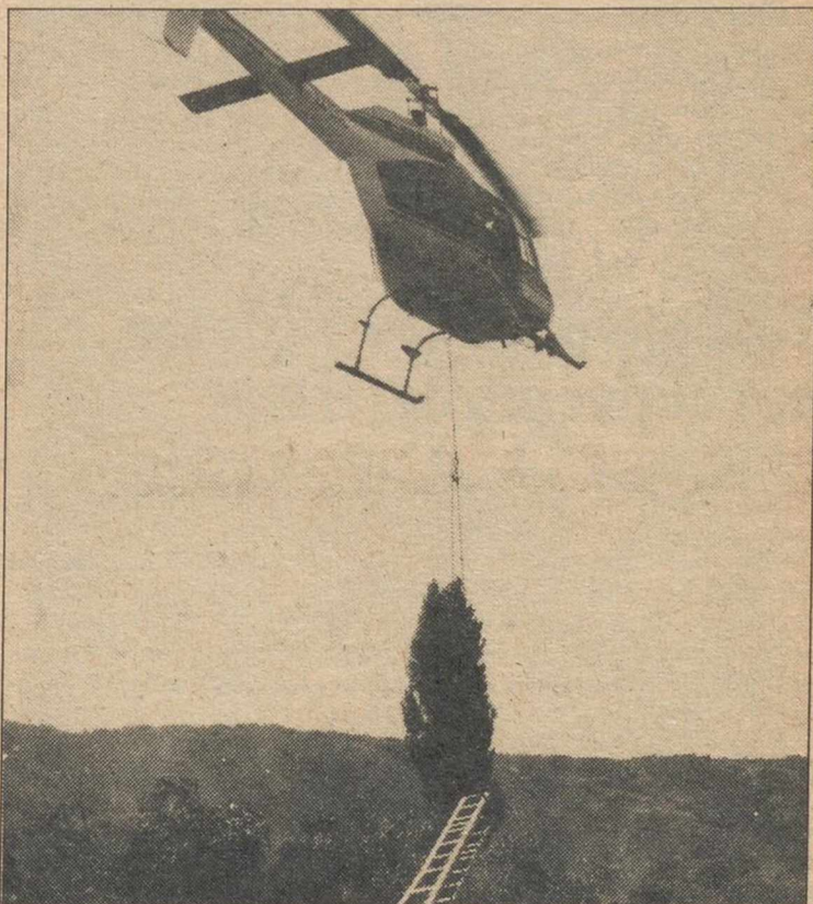
El helicóptero en el momento de empezar a alzar una de las torretas. Estas no deben superar los 500 kilos y cuando lo sobrepasan se divide en dos.
