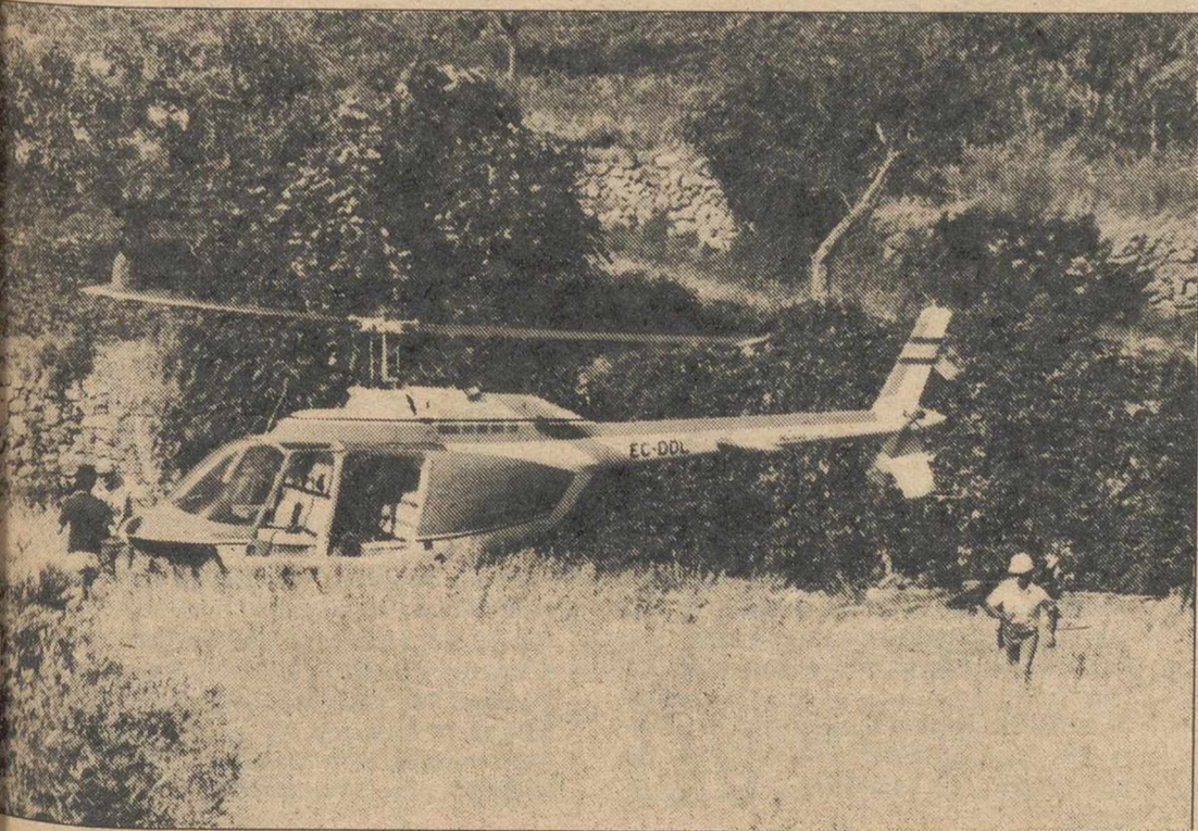
Es la primera vez que se utiliza en Albacete un helicóptero para el tendido de una red eléctrica.
