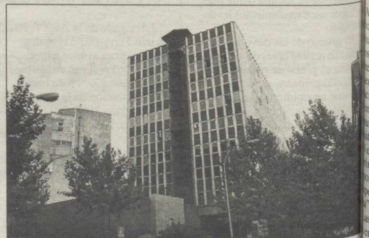
La oficina de Correos está en el edificio de Servicios Múltiples
