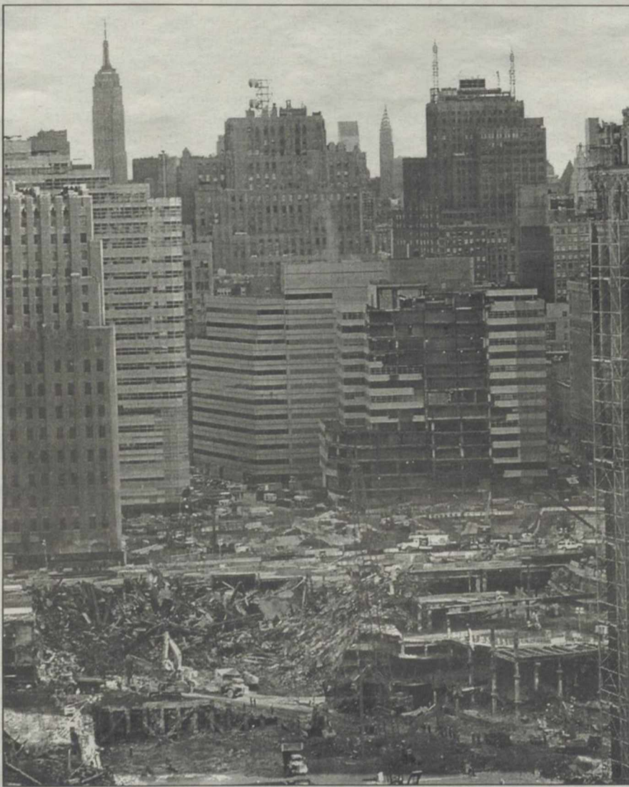
Equipos de emergencia continúan limpiando el solar del World Trade Center
