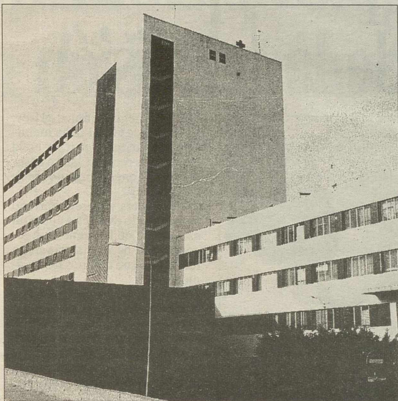
En la imagen, el Hospital del Carmen, que sufre importantes deficiencias.
