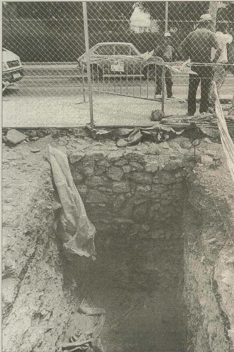
Primera cata realizada, la de mayor profundidad, en la obra.
