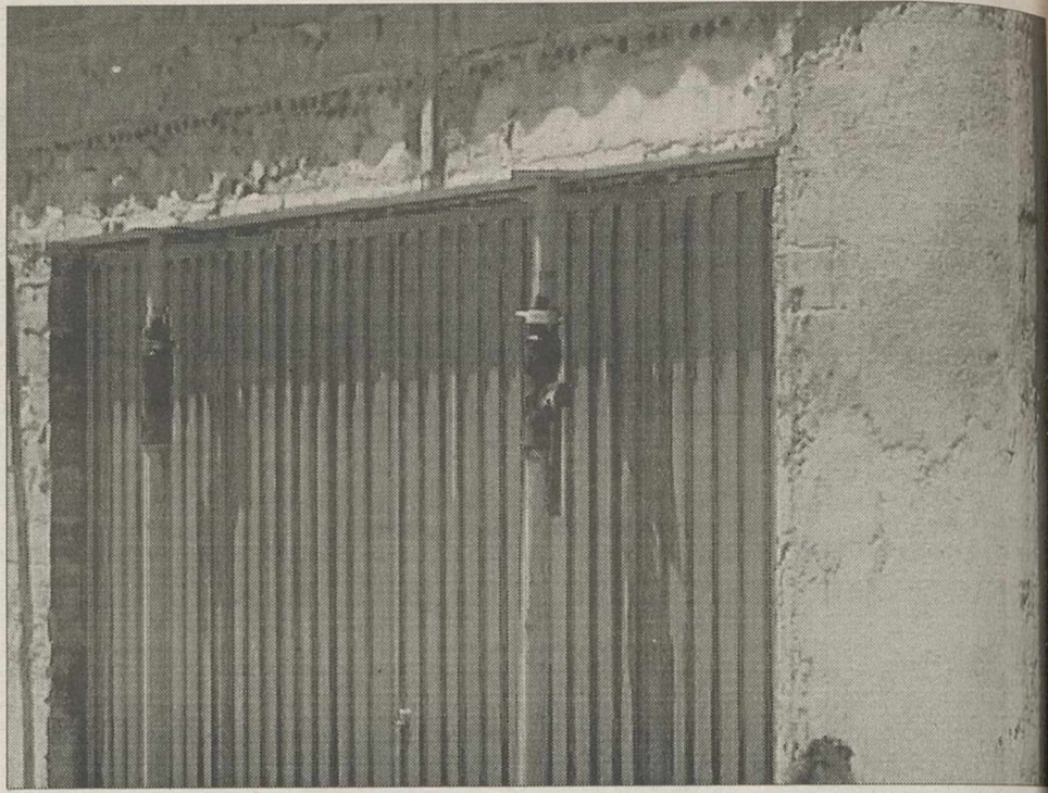
A.M. Los alumnos de construcción están levantando una nave-taller para el año que viene.
