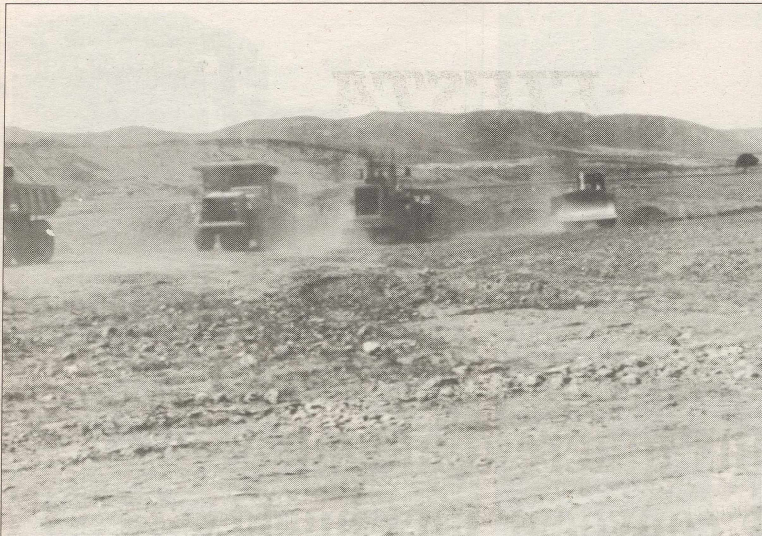
Elcogás, cuyas obras aparecen en la foto, fomentará el empleo de mano de obra de la comarca y promoverá la participación de las empresas locales
