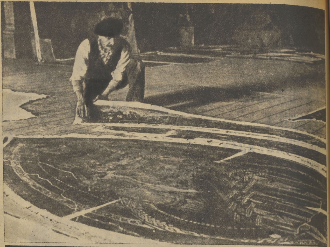
Restauración de una tela que será aplicada a un muro
