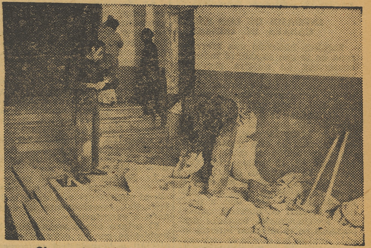
Obras en el recinto destinado a las nuevas oficinas de Turismo. — (Fotos Finezas)
