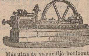
Máquina de vapor fija horizontal
