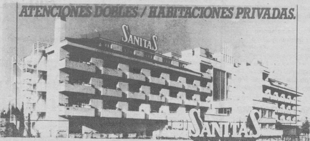
CLINICA SANITAS, carretera de La Coruña, Km. 10'200 (Madrid)
