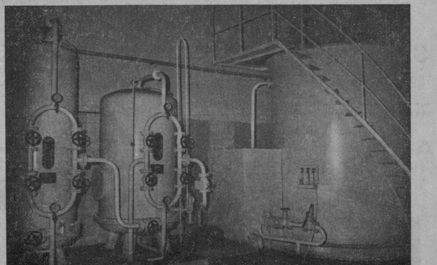
(Un detalle de los circuitos de tratamiento de agua, estación depuradora y filtros de «LA REVOLTOSA» en su planta embotelladora del Polígono industrial en Segovia)
