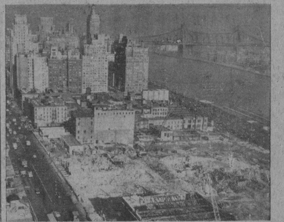
Varios edificios han sido demolidos en Manhattan (Nueva York) para proceder a la construcción de la sede permanente de las Naciones Unidas. En la foto vemos un aspecto de las obras de demolición.
