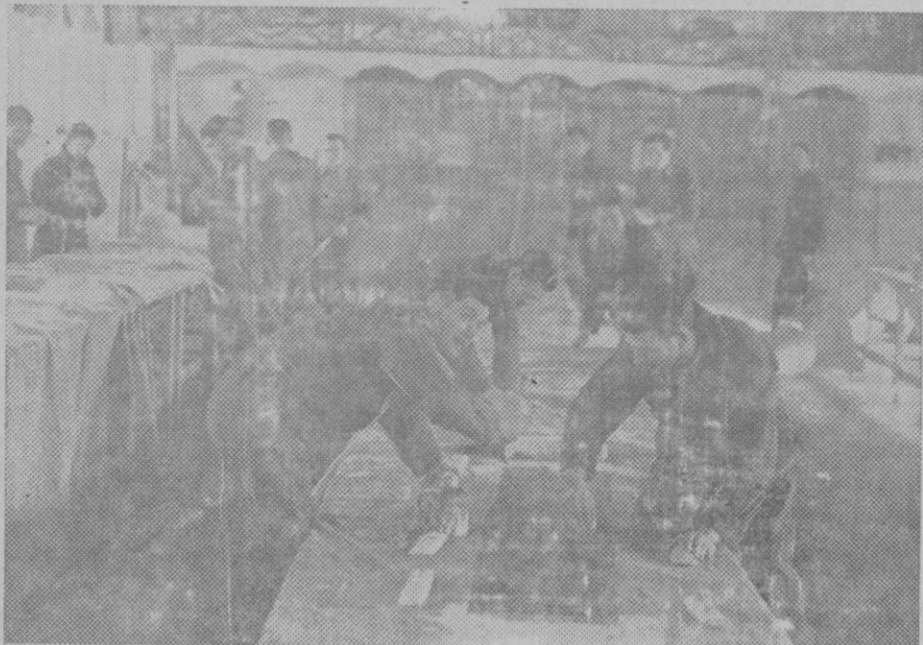
GUADALAJARA LA CONSTRUCCION DEL AEROSTATO ESTRATOSFERICO DEL SR. HERRERA.—Soldados pegando los «usos» del globo estratosférico que se esta construyendo en el Parque de Aerostación de Guadalajara.
