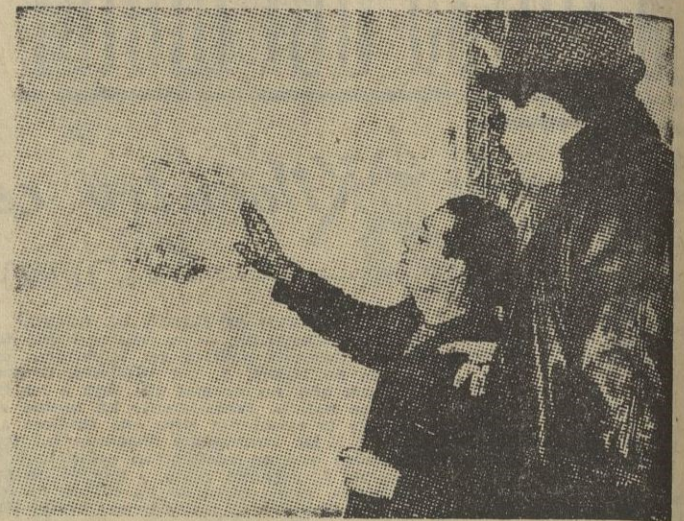
El portero de la finca muestra a nuestro redactor el boquete—ya reparado—por donde penetró el ladrón.
