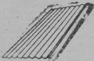
Boveditas patentadas para la construcción de techos. Canales indestructibles que no se oxidan ni se bollen como los de zinc, plomo etc. Depósitos para agua. Depósitos para waters, muy económicos. Tubos para conducción de aguas. Todo fabricadopor Rocilla a base de cemento y amielto.
