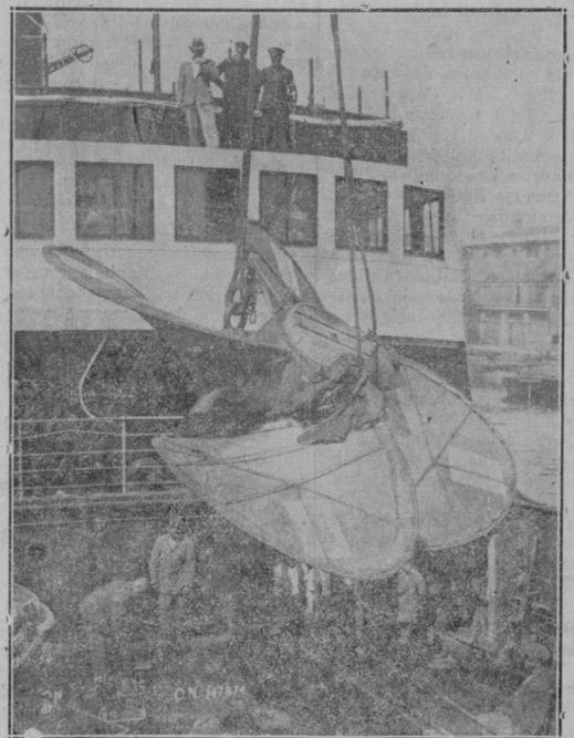
**LA PRIMERA HELICE PARA EL BARCO MAYOR DEL MUNDO.**— La primera de las cuatro hélices para el nuevo buque de la Cunard Line en construcción, ha sido embarcada a bordo del vapor «Copeland». El nuevo buque que se llamará «Britannia» y que seguramente será lanzado al mar en Septiembre próximo, será el mayor del mundo y desplazará 75.000 toneladas. Cada una de sus 4 hélices pesa 35 toneladas y vale más de 7.000 libras esterlinas
