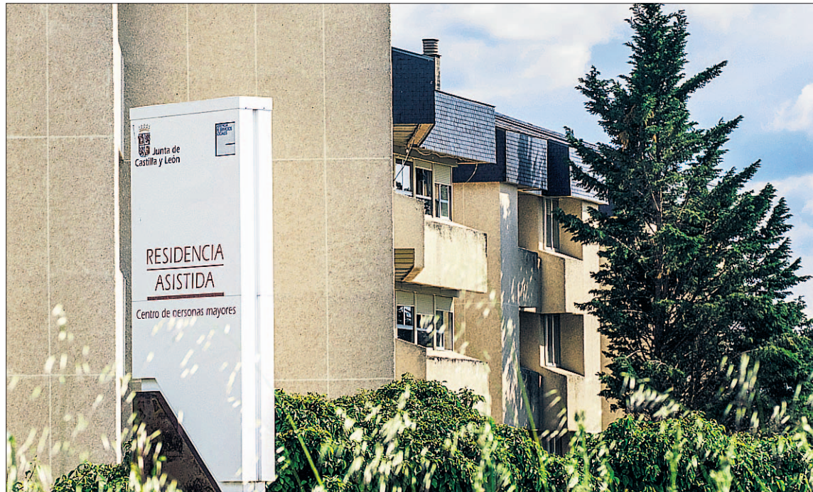
Fachada de la Residencia Asistida de la Tercera Edad, ubicada en la carretera de Soria. / KAMARERO
