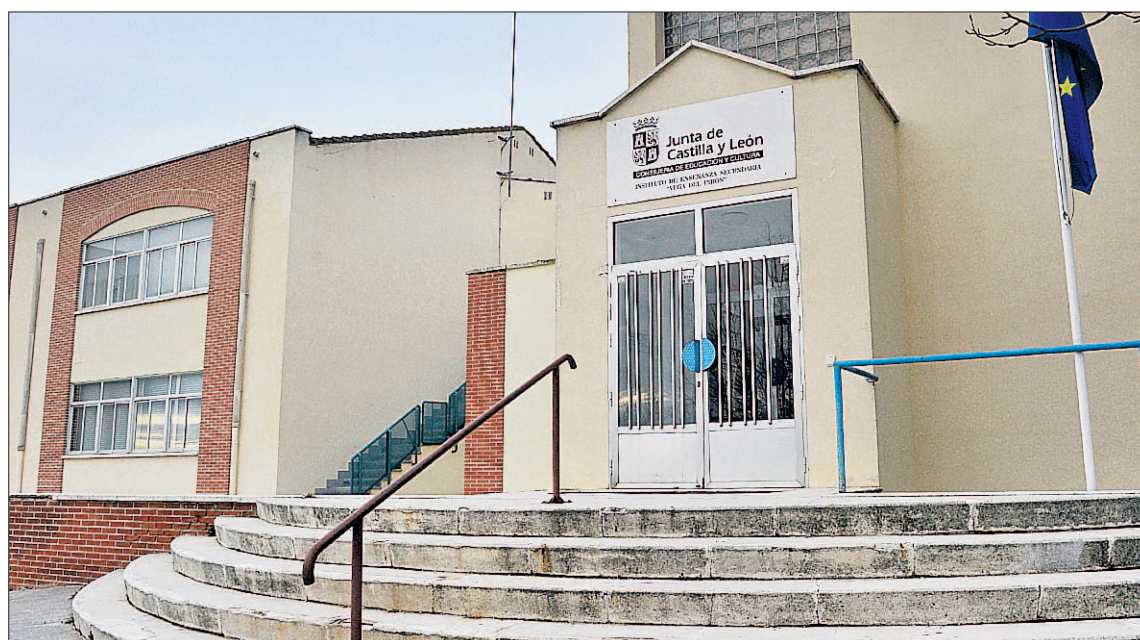
Se prevé que las obras comiencen en enero de 2019 y tengan dos meses de duración. / KAMARERO
