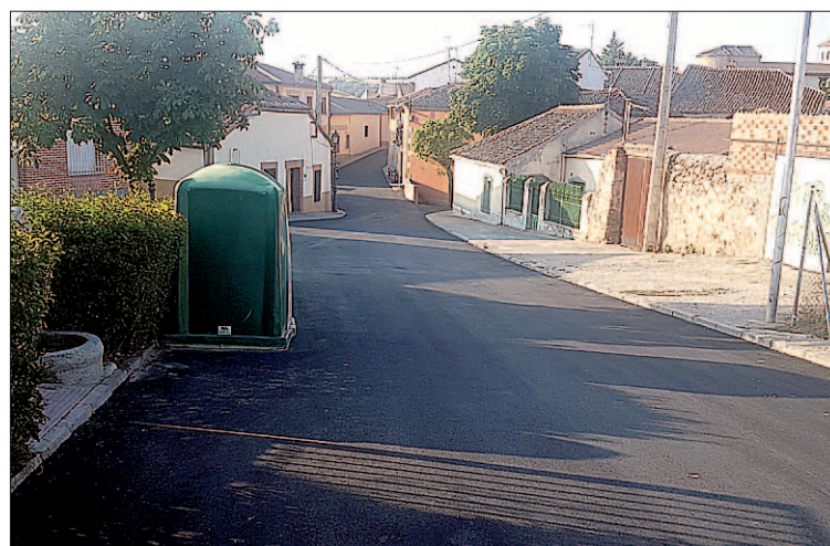
Estado de la calle Las Salesas tras su rehabilitación. / EL ADELANTADO
