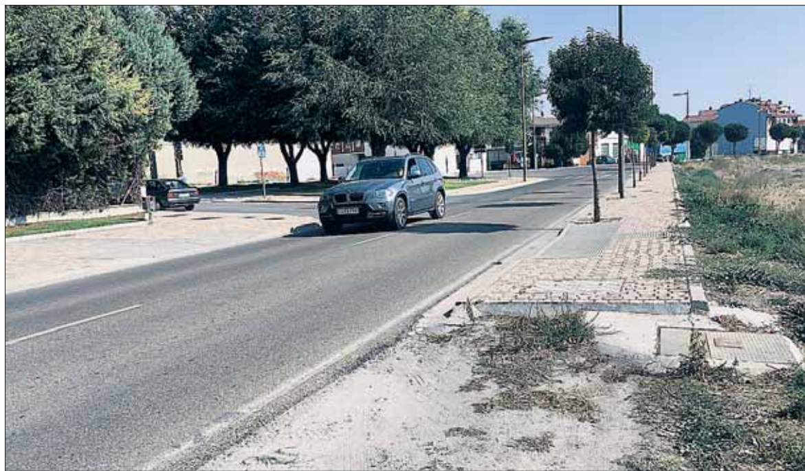
Acera de Olmedo en su margen izquierdo, que será acondicionada con los mismos materiales. / C.N.
