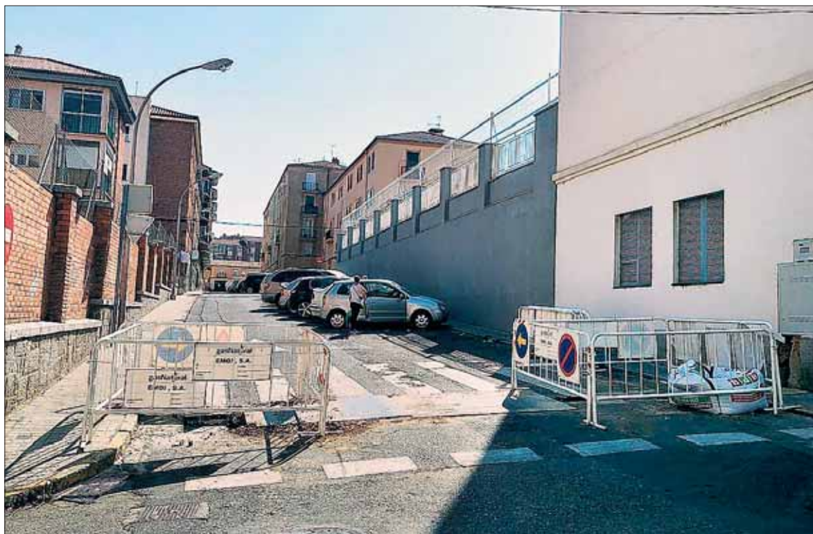
La empresa Gas Natural ha ejecutado obras en la calle General Gutiérrez Mellado para suministrar gas al colegio Villalpando. / E. A.
