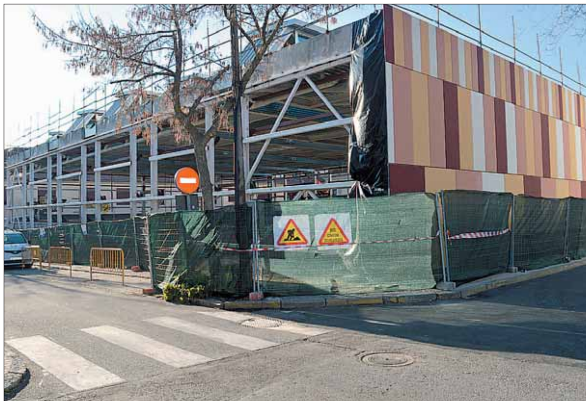
Imagen captada en enero cuando comenzó la instalación de los paneles exteriores del pabellón./ TAMARA DE SANTOS
