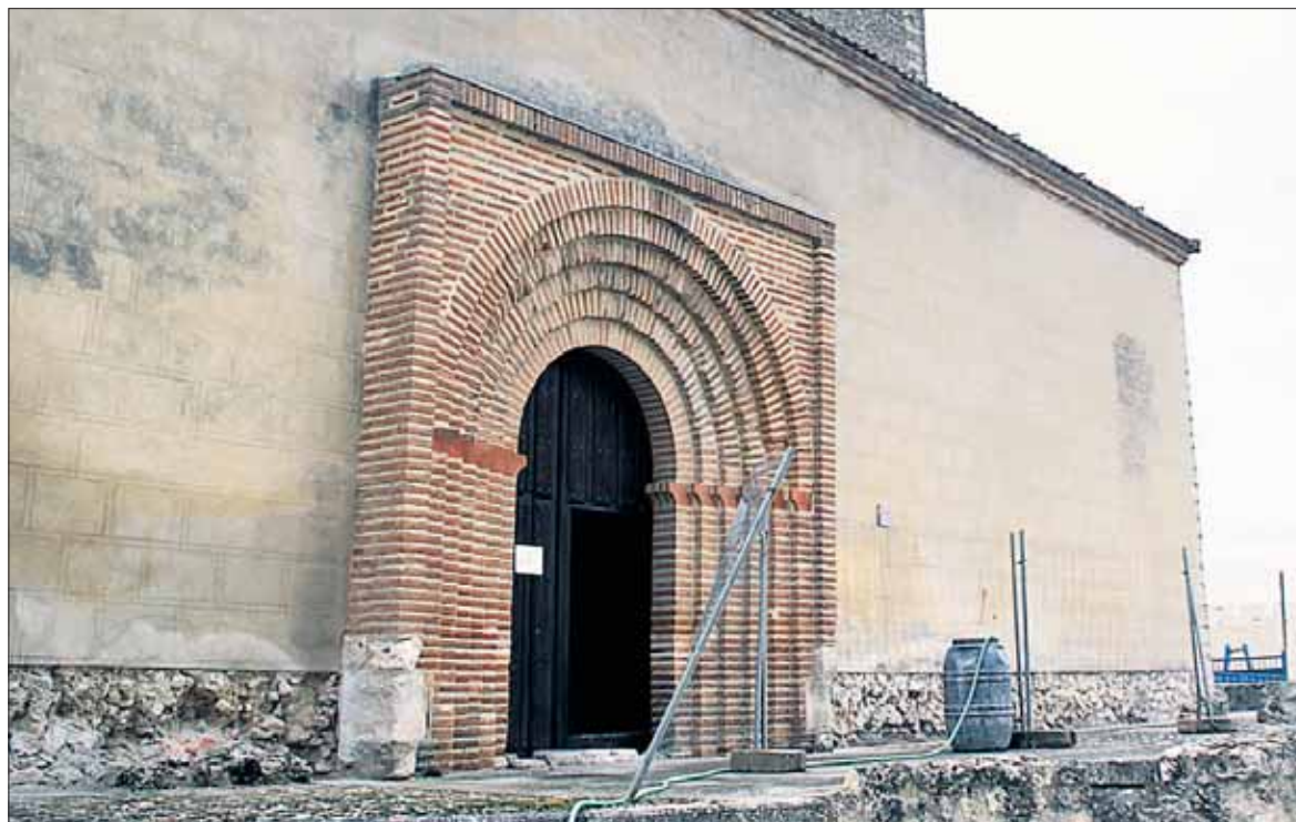
No será necesaria la instalación de andamiaje, ya que los obreros se moverán con maquinaria. / C. N.
