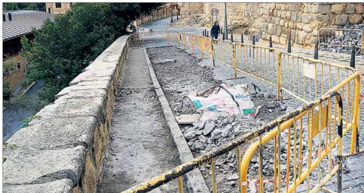
Estado que presentan las obras en el vial de acceso al Paseo del Salón. / KAMARERO
