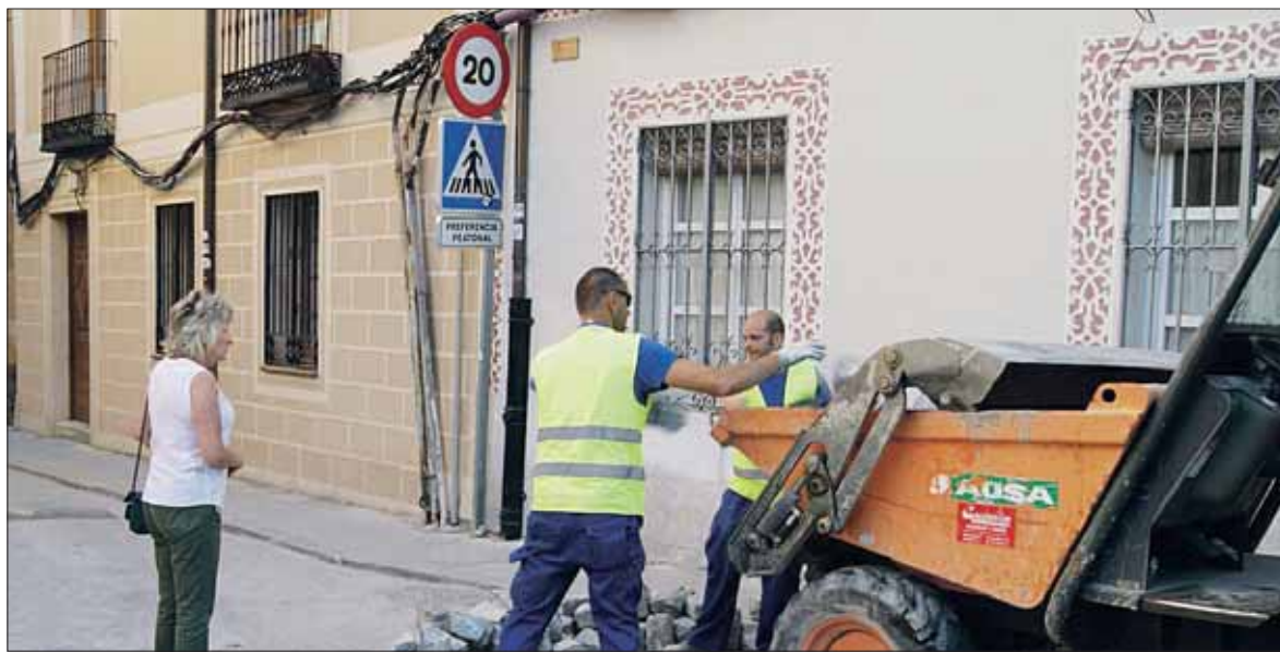
La concejala de Obras, Paloma Maroto, vigiló los trabajos de remodelación de la calzada en la calle Daoiz. / EL ADELANTADO
