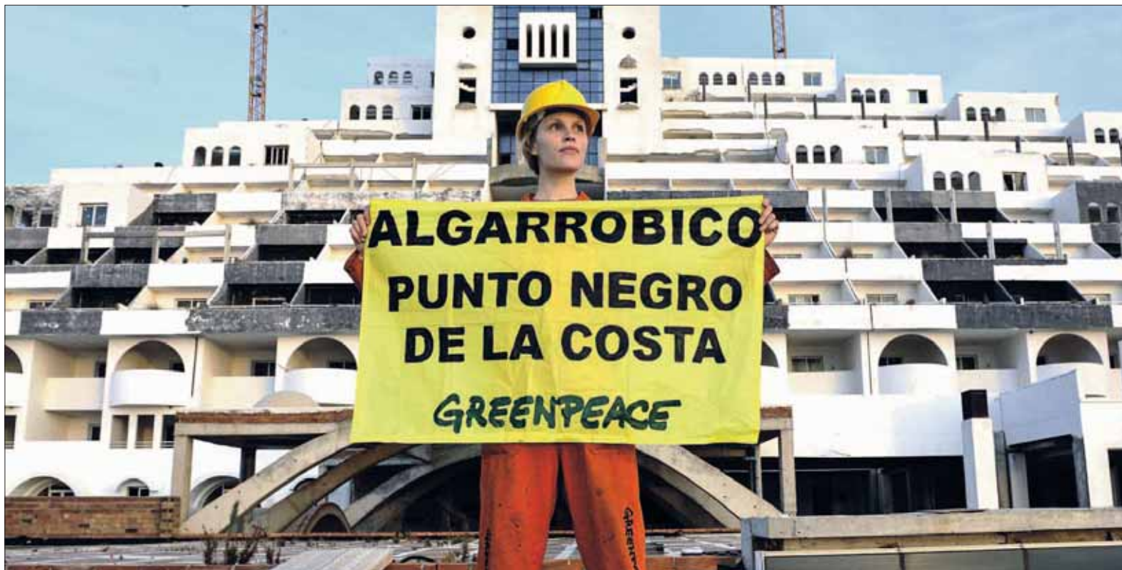
Una activista de Greenpeace frente al polémico hotel situado en la costa almeriense de Carboneras, que será finalmente demolido. / EFE
