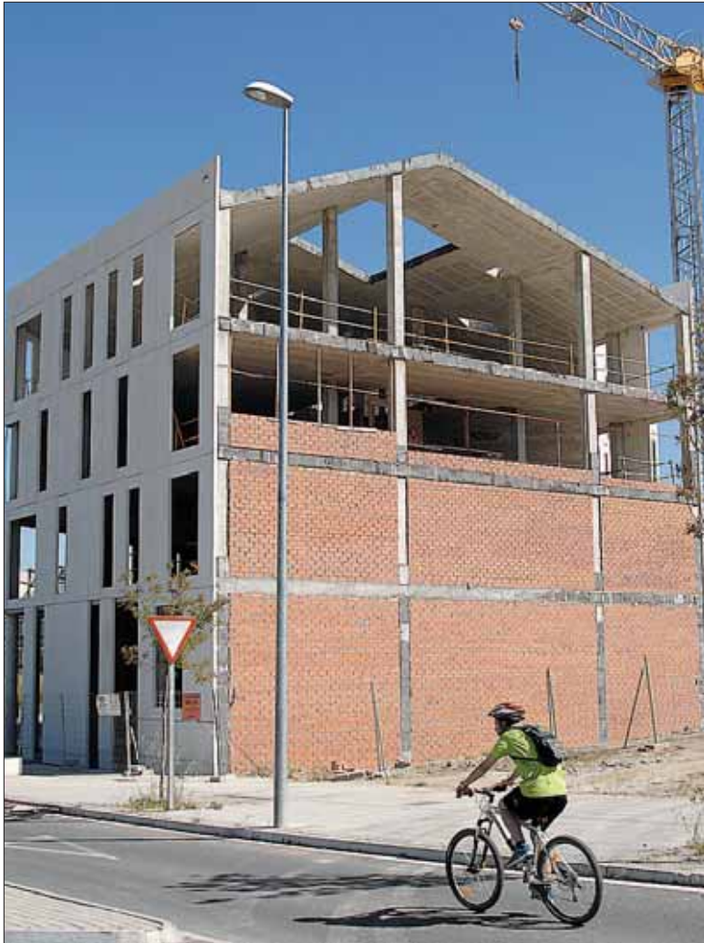
Viviendas en construcción en el nuevo barrio de la capital segoviana. / E. A.
