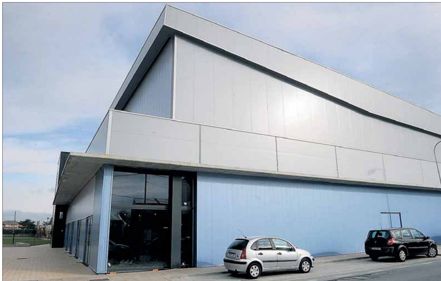
Fachada del nuevo pabellón polideportivo de Nava de la Asunción, aún con mucha obra por realizar antes de poder estar operativo. / KAMARERO
