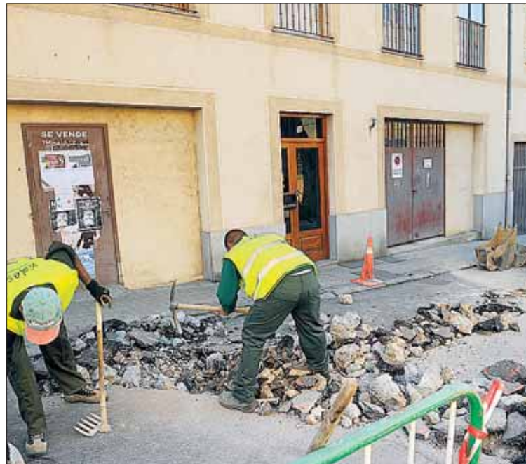
Los trabajos previstos concluirán definitivamente el miércoles. / JUAN MARTÍN
