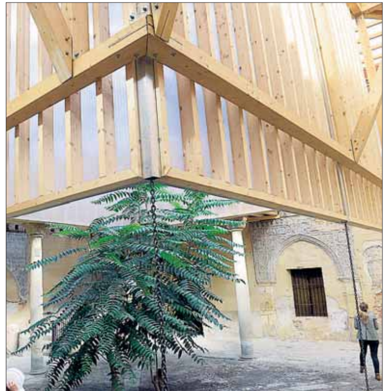
Estructura que sostiene muros y protege forjados del palacio. / KAMARERO
