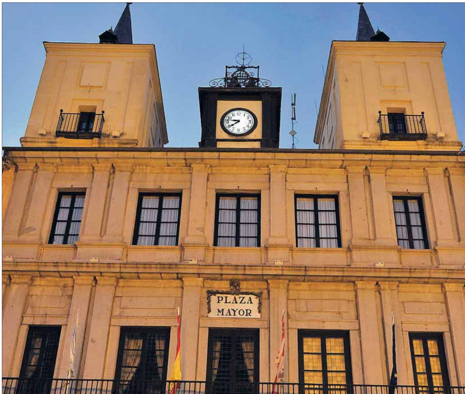
Fachada principal del Ayuntamiento de Segovia, que tiene la mayor deuda viva de toda la provincia, superando los 21 millones de euros. / KAMARERO
