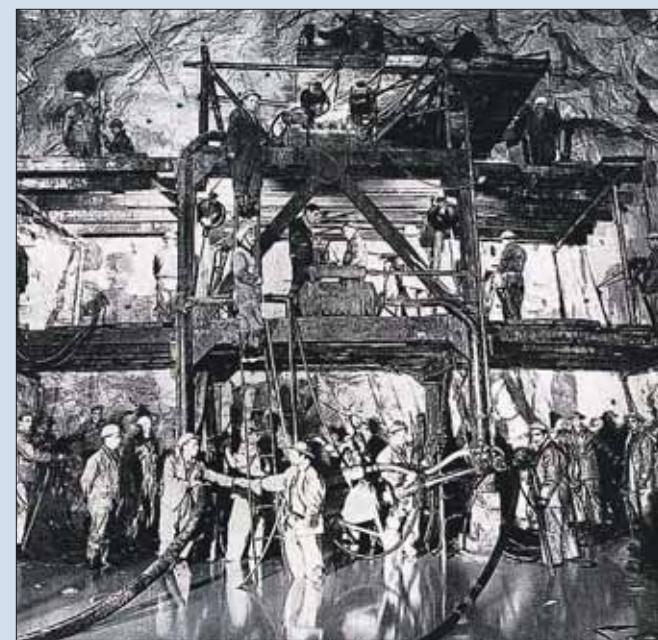
Imagen de las obras del primer túnel en los años sesenta. / ABERTIS
