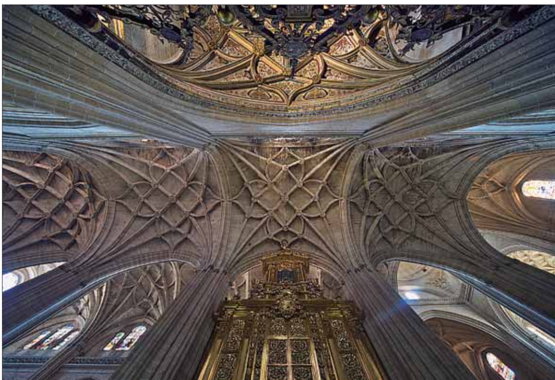
Imagen de archivo del interior de la cubierta de la Catedral de Santa María de Segovia. / KAMARERO
