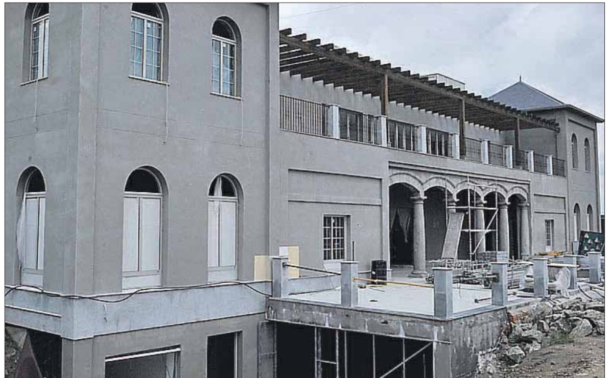
Imagen de las obras que se están llevando a cabo en La Faisanera para acoger un Palacio de Congresos. / KAMARERO
