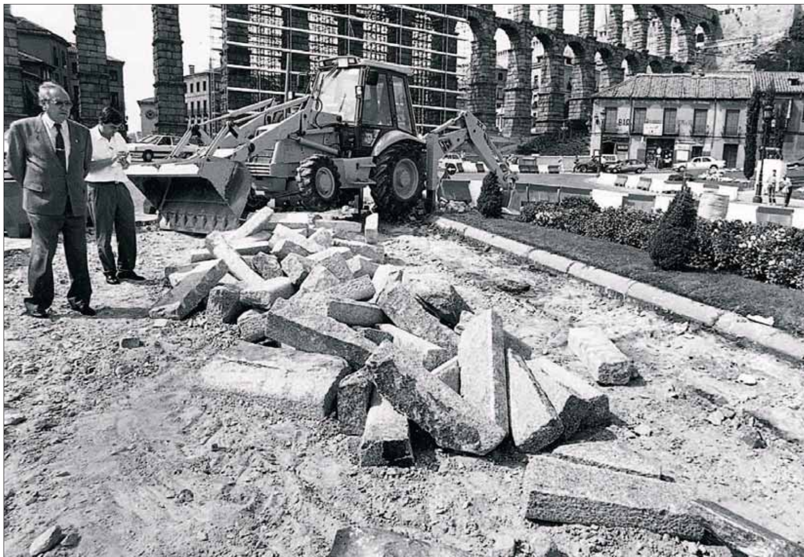
El alcalde Ramón Escobar observa las obras de construcción de la rotonda de la Plaza de la Artillería. Entre tanto, el Acueducto se cubría de andamios. / FERNANDO PEÑALOSA
