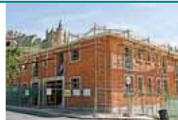
Imagen del polémico edificio en construcción en la calle San Marcos.
