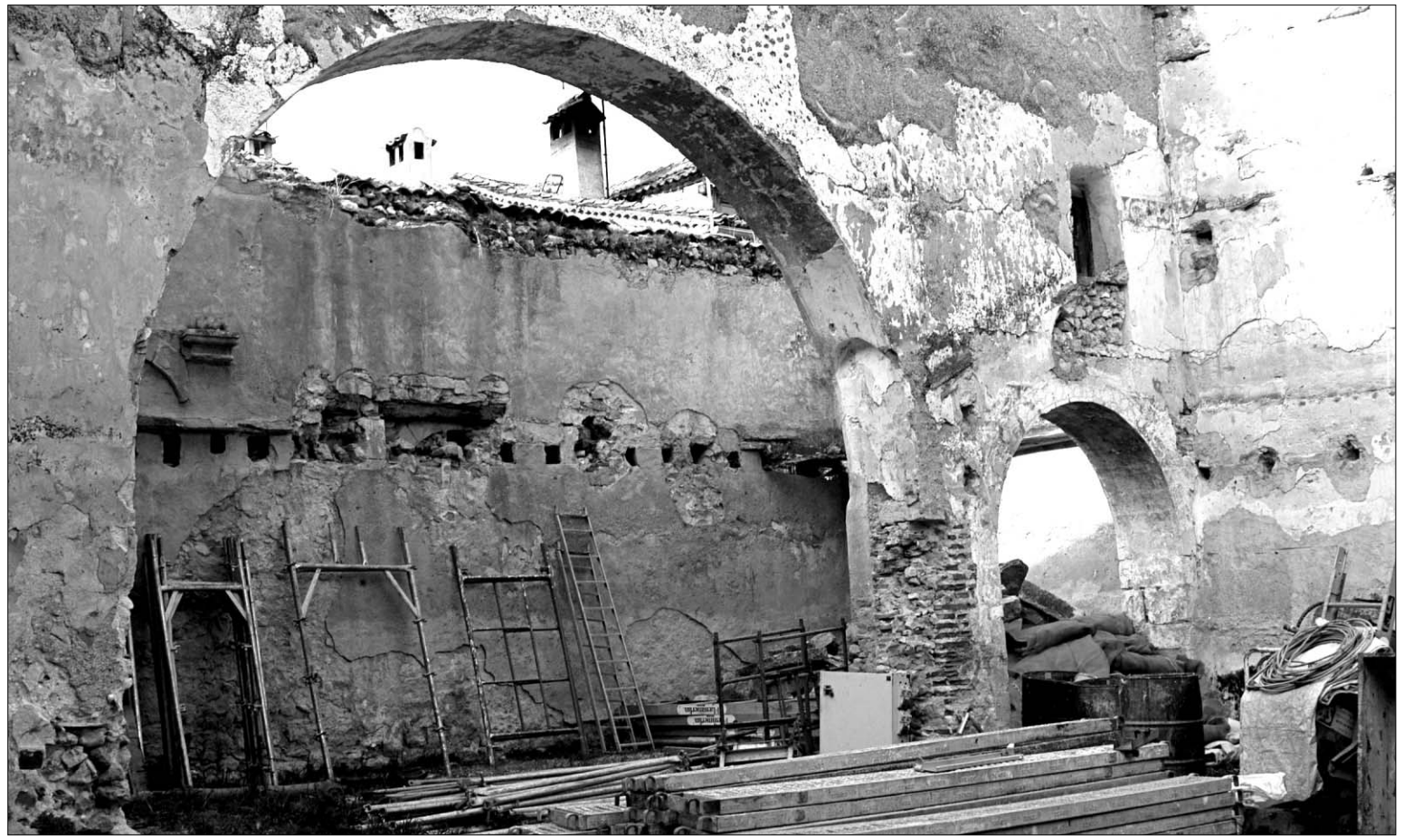
Las obras de rehabilitación integral de la Iglesia de Santo Domingo en la Villa de Pedraza permitirán a la Fundación disponer al fin de su sede. /GUILLERMO HERRERO
